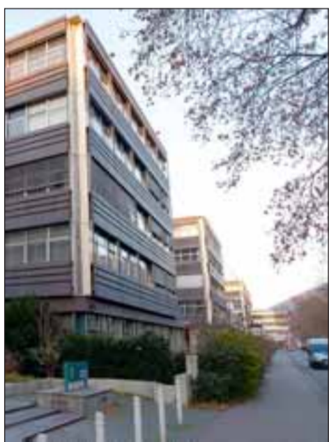
Der Abriss ist beschlossene Sache: Die Gerichte und die Staatsanwaltschaft in der Bahnhofstraße müssen weichen. Foto: Kresin
